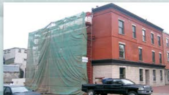
SYNDICAT DES COPROPRIÉTAIRES DU 2030 ST-ANTOINE OUEST Reconstruction des sections des murs de briques avec des ventres de bœuf
