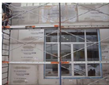
Fig. 11 Pose de l'enduit de ciment-acrylique
