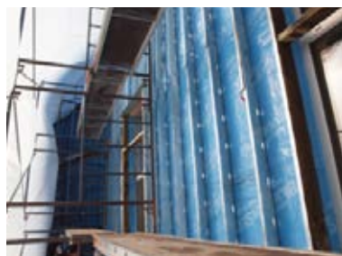
Fig.9 Pose des profilés métalliques verticaux
