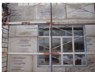
Fig.10 Mise en place des panneaux de ciment-léger
