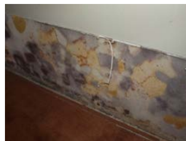
Fig. 7 Pourriture sévère du bas du mur dans une unité de copropriété due à la défaillance d'un mur à parement isolant
