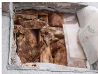
Fig. 4 Pourriture avancée du panneau intermédiaire
