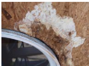
Fig. 5 Pourriture du panneau intermédiaire autour des ouvertures non protégées de solins flexibles
