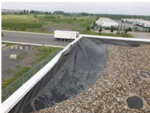
Toiture mal fixée arrachée par le vent.
