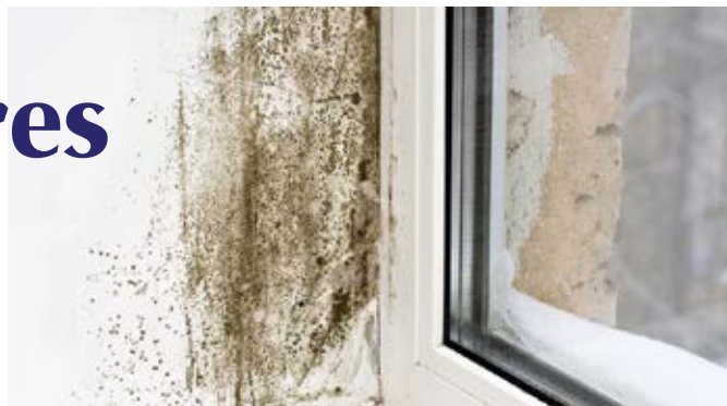
Moisissures sur placoplâtre
