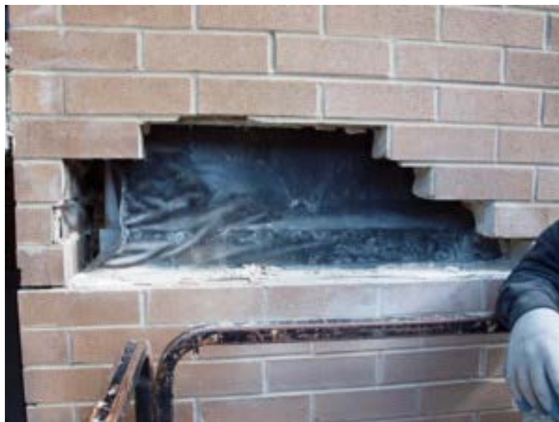
Figure 4 Les percées exploratoires permettent de préciser les mesures préventives et de découvrir les conditions dangereuses
