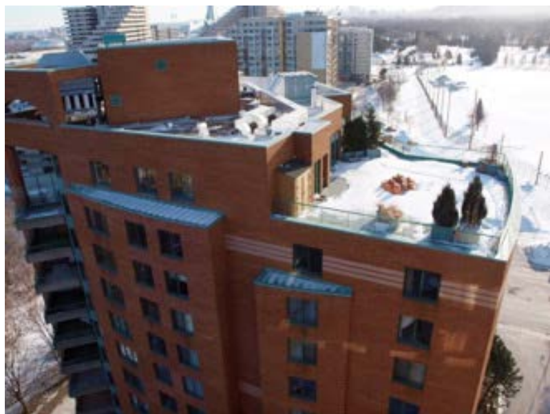
Figure 2 Une géométrie de bâtiment complexe augmente le temps d'inspection des façades.
