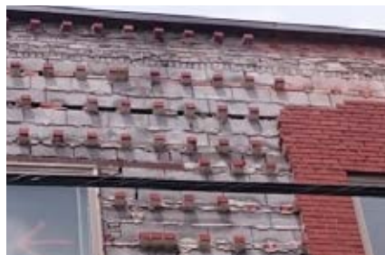
Fig. 3 Vue d'un arrière mur massif après enlèvement du premier rang de briques (les boutisses sont visibles).
