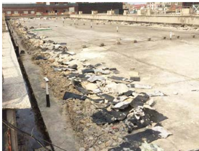
Mortaise (Le résultat de travaux de réparation sur une toiture de Beijing, Chine. De devoir briser la couche de béton coulée systématiquement sur la membrane cause beaucoup de débris et maux de tête aux travailleurs.)
