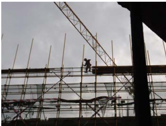
(Travailleur non attaché avec risques de chute grave.)
