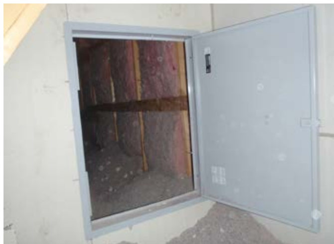
Image 1 – Porte coupe-feu dans un mur en construction dans l'entretoit – réf : Nivoex inc.
