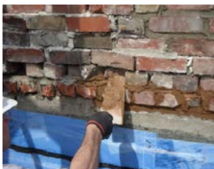
Fig. 4 Travaux de stabilisation de l'arrière-mur.
