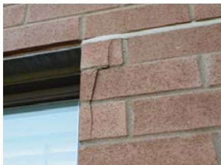
Fig. 8 Fendillement localisé près des ouvertures (type parement)
