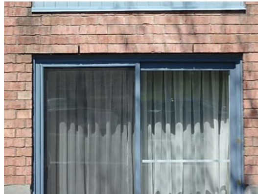
Fig. 1 Chantepleure typique au- dessus d'une porte-fenêtre
