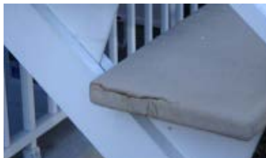
Fig.4 Fendillement de la fibre de verre
