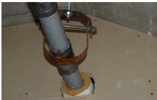
Photo 3. Tuyau et panneaux non scellés
