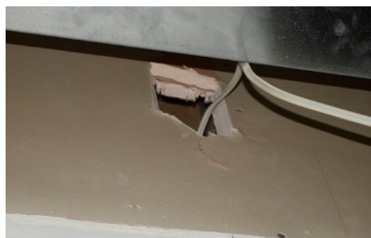
Photo 1. Ouverture non scellée dans une cloison coupe-feu
