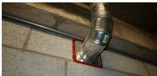
Photo 5. Exemple de pénétration avec scellant coupe-feu conforme
