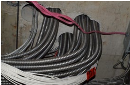
Photo 2. Filage électrique en couette sans scellement coupe-feu
