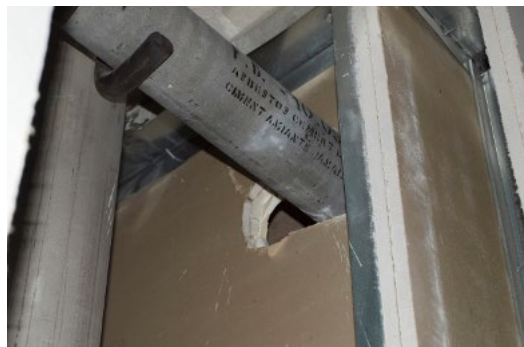
Photo 4. Point de pénétration d'un tuyau de plomberie dans un vide technique sans aucun scellement coupe-feu
