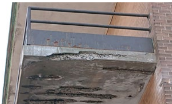
Fig. 3. Les fragments de béton lâches doivent être retirés promptement
