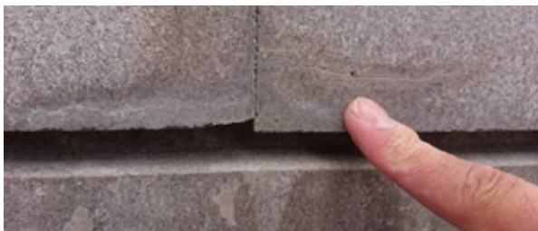
Fig. 1. Une micro-fissure laisse présager des dommages à venir.
