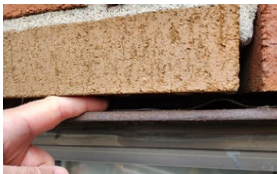
Fig 4. Condition dangereuse : il ne devrait pas y avoir d'espace entre le parement de brique et le linteau qui la soutient !
