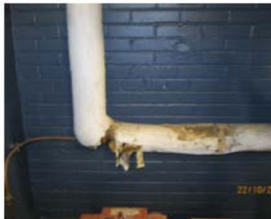
Photo : calorifuge sur une conduite, afin d'empêcher la déperdition de la chaleur
