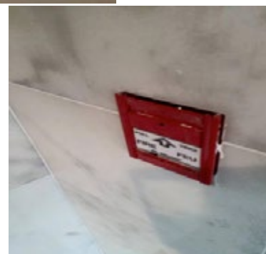
Panneau incendie et station manuelle installé trop haut!
