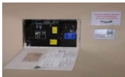
Panneau incendie installé dans le mauvais sens ici à Montréal.
