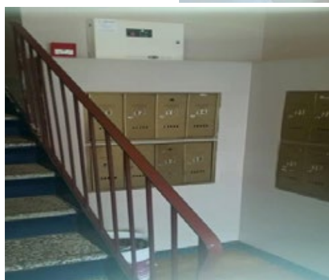
Panneau incendie et station manuelle installé trop haut!
