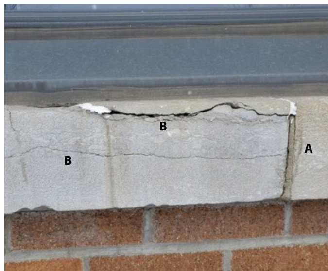
Figure 2 : (A) Joint vertical entre deux morceaux formant l'allège. (B) Litage d'argile horizontal
