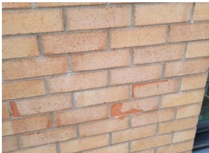
Figure 5 : Efflorescence blanche et délamination de la brique
