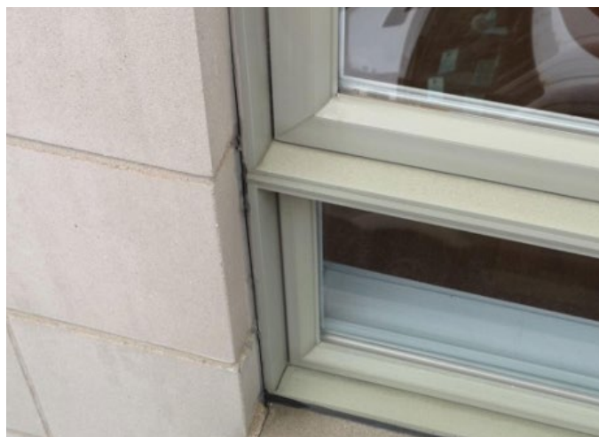
Figure 3 : Détérioration importante du produit calfeutrant à la jonction entre le parement et le cadre de la fenêtre
