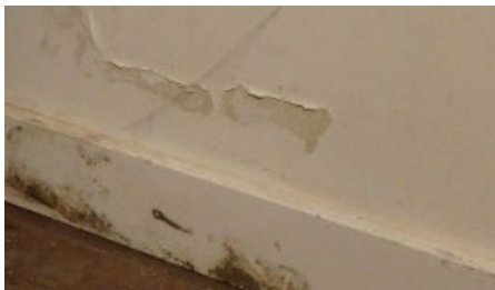
Fig.1 Signes apparents de moisissures
