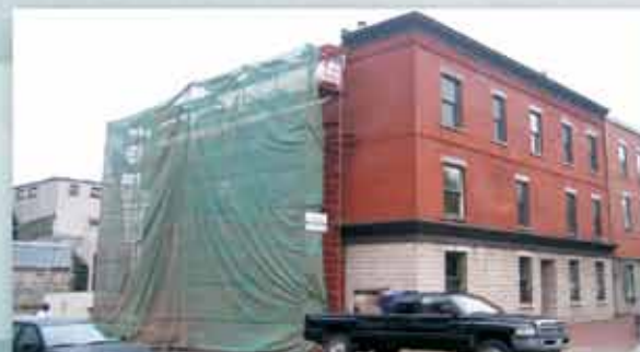
SYNDICAT DES COPROPRIÉTAIRES DU 2030 ST-ANTOINE OUEST Reconstruction des sections des murs de briques avec des ventres de liouf
