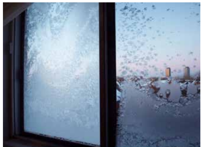
Fig.4 Des coupe-froids usés favorisent le givrage entre les volets
