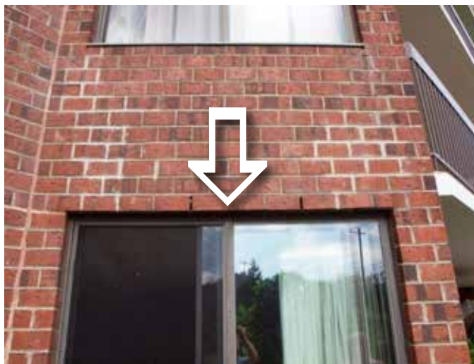
Fig.3 Lorsque l'ouverture est déformée, il faut une intervention sur le mur.
