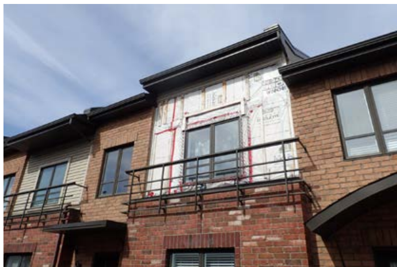
Figure 1 - Mur extérieur laissé sans protection – source : Nivoex inc.
