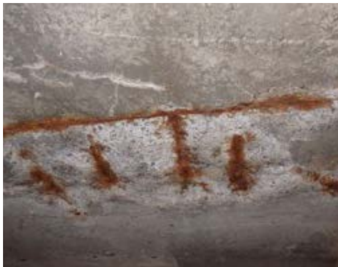
Figure 2 : Délamination du béton dans un stationnement souterrain. Crédit Photo : Raphaëlle Faucher
