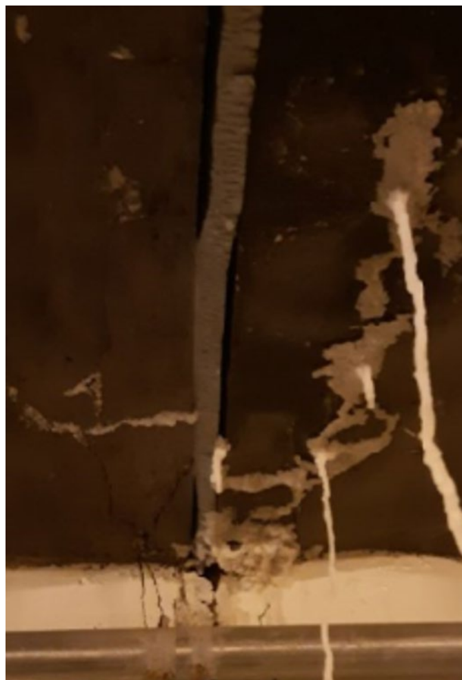
Figure 1: Stalactites dans un stationnement formé par l'écoulement de l'eau contaminé aux sels de déglacage
