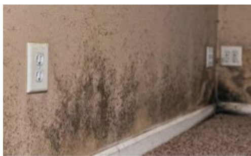
Fig 5. Moisissures dues à la défaillance du drain
