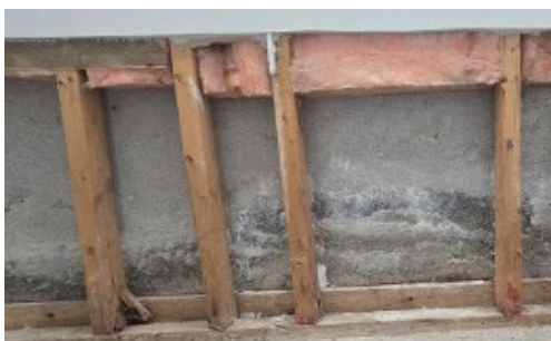
Fig 4. Efflorescence du béton au bas des murs
