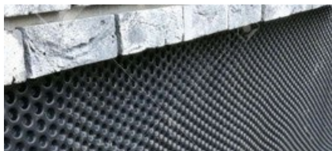
Fig 6. Membrane drainante pour fondation
