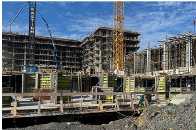
Une baisse des mises en chantier
